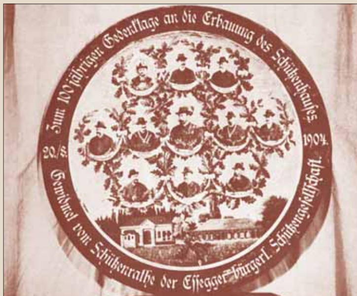
Streljačka ploča napravljena u povodu obilježavanja 100-godišnjice izgradnje Streljačke kuće u Gradskom vrtu 1904. godine
